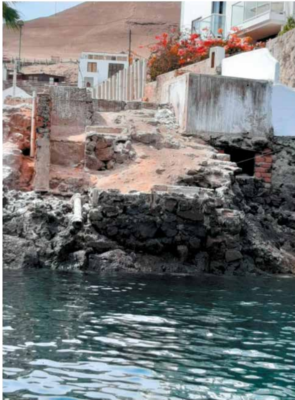
Figura 1. Tubería que descarga aguas residuales en el mar de Pucusana. La presencia de estos elementos es evidente en esta playa.
